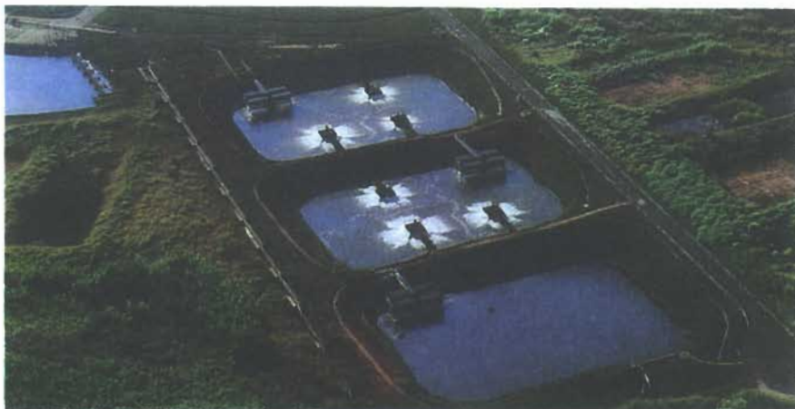
Lagoas de aeração na Refinaria de Paulínia, São Paulo.
