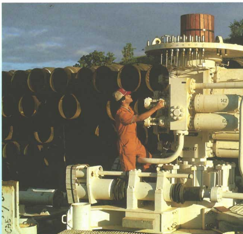
Parque de tubos em Macaé (RJ)
