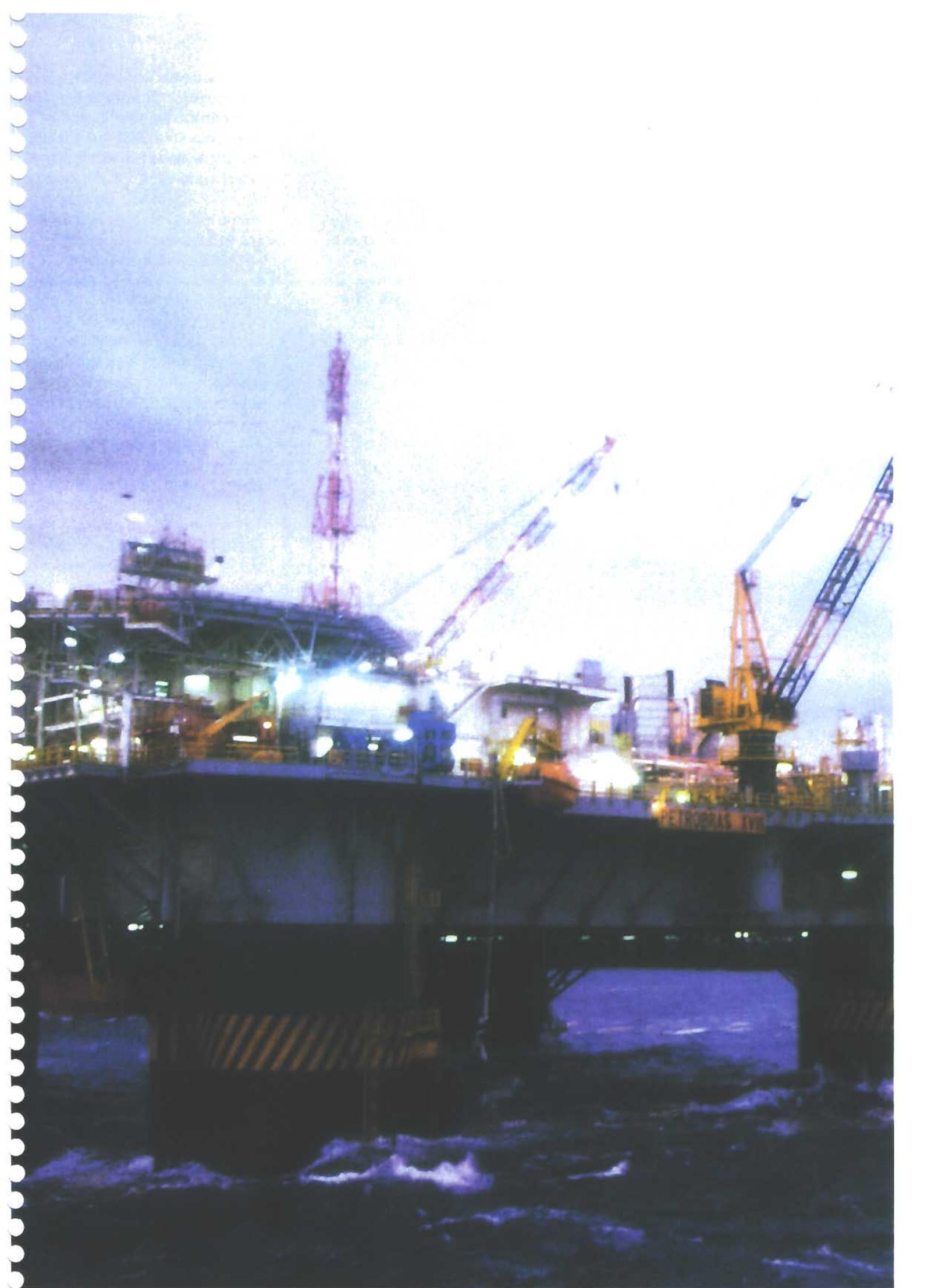
Plataforma semi-submersível P-XVIII. É a maior do mundo e foi totalmente projetada pelos técnicos da Petrobras para operar no Campo de Marlim, na Bacia de Campos. Esta plataforma recebe o óleo proveniente do poço MRL-4, recordista mundial em produção submarina (1.027 metros de lâmina d'água).
